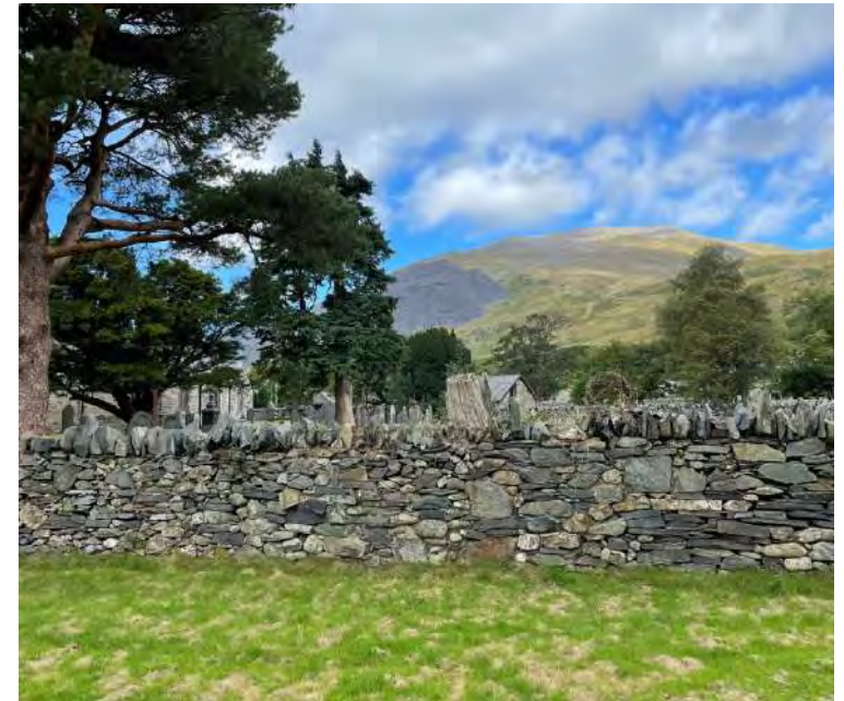
19 Waliau rwbel, gwahanol gerrig maes a chwarel. Sylwer ar domenni rwbel Dinorwig yn y cefndir.
