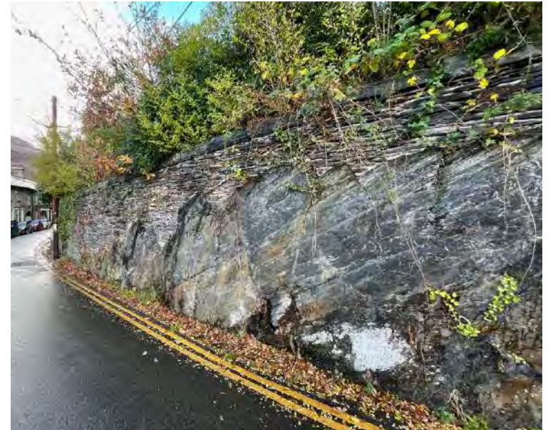
29 Creigiau gwaelofdol sylweddol ar ochr cyffordd Gellilydan, efo walio rwbel arnynt i greu uchder cyson. (2021).
