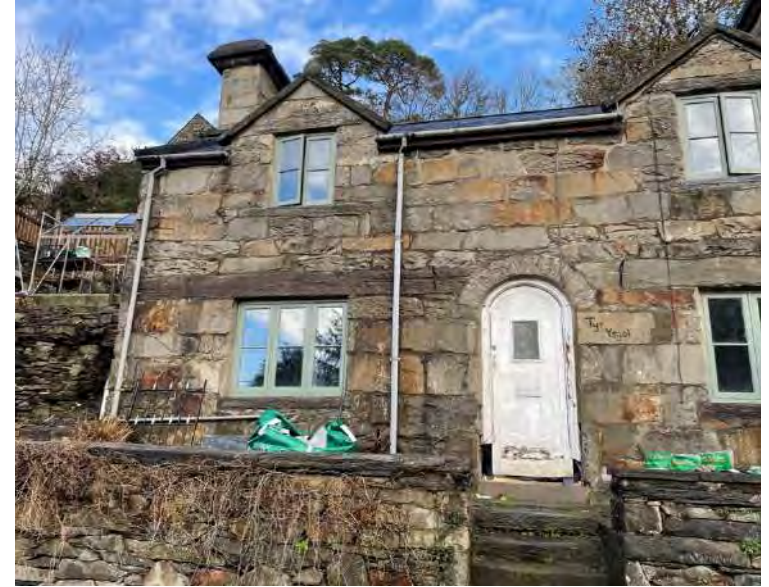
28 Linter sgist mawr ymysg haenau cerrig breision. Sylwer ar y cerrig copa sgist hefyd. Tŷ'r Ysgol (2021).
