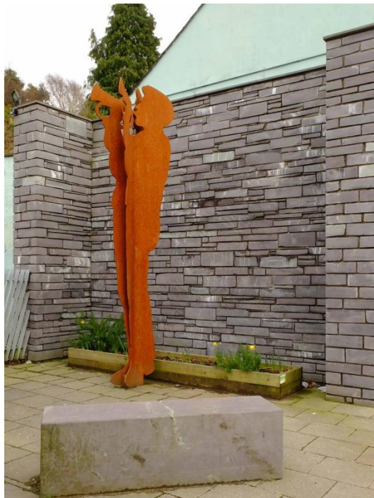
Ffigwr 29 Mae llechi yn parhau i fod yn ddeunydd adeiladu pwysig, ac fe'i defnyddiwyd yma i waliau cynnal Llys Dafydd yng nghanol y dref.
