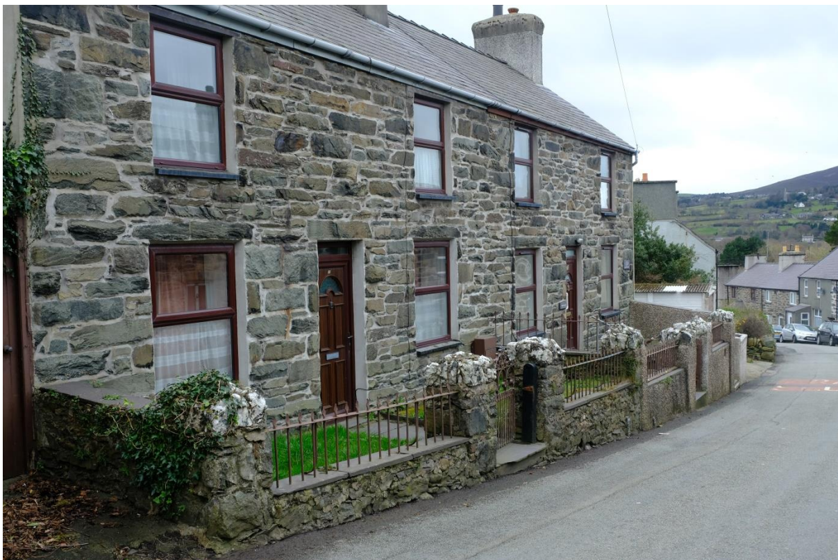
Ffigwr 21 Mae mwyafrif o dai Bethesda, fel y pâr yma ar Ffordd Penybryn, wedi eu hadeiladu o gerrig a gloddiwyd ac a osodwyd mewn haenau bras. Mae meini copa pileri'r glwyd yn ddarnau bach o gwards, oedd yn sgil-gynnyrch cloddio am lechi.
