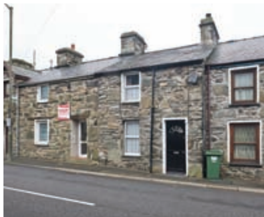
Tai trefol ar hyd y briffordd y cwblhawyd eu llinell yn 1825. Mae gwahaniaethau yn y gwaith maen yn dangos bod llawer o'r terasau wedi'u codi gan fwy nag un adeiladwr (Hawlfraint y Goron: CBHC).
