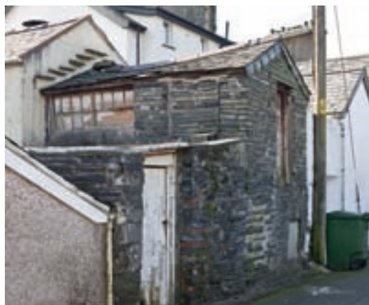
Prin yw'r enghreifftiau o lechi fel deunydd codi wal yn y dref, ond weithiau fe'i defnyddiwyd ar gyfer adeiladau allan (chwith pellaf) a strwythurau atodol (chwith) (Hawlfraint y Goron: CBHC).
