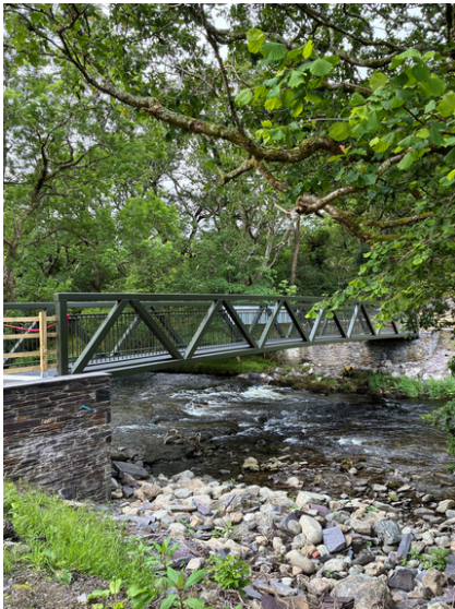
Pont Sarnau, Bethesda
