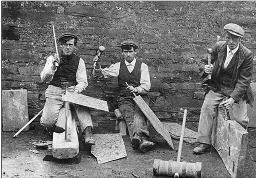
Slate splitters, Llechwedd © Gwynedd Archives
